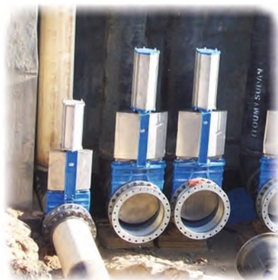
Instalace na směšovací komoru
