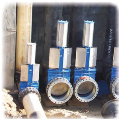
Instalace na směšovací komoru
